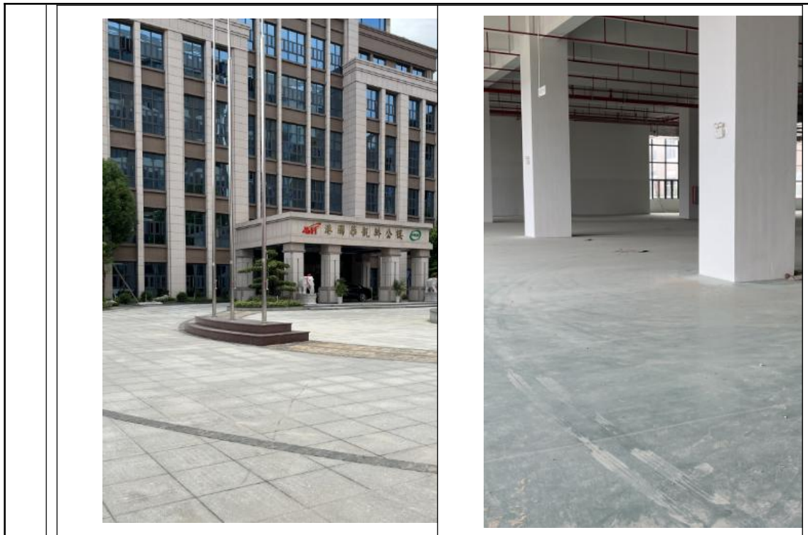
图 11 项目地面硬化图
