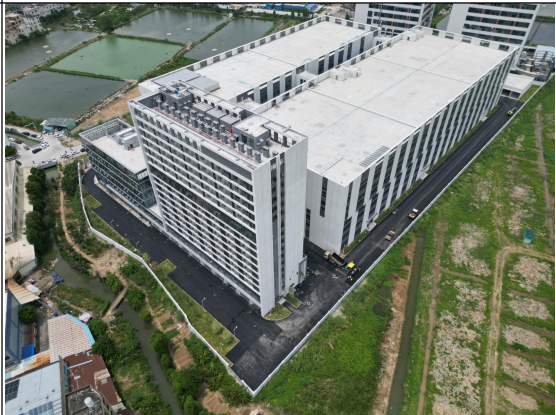
建筑物（东南方向）
