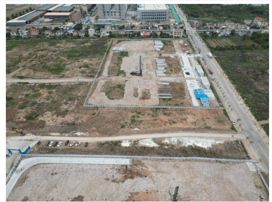
项目东面为工业用地
